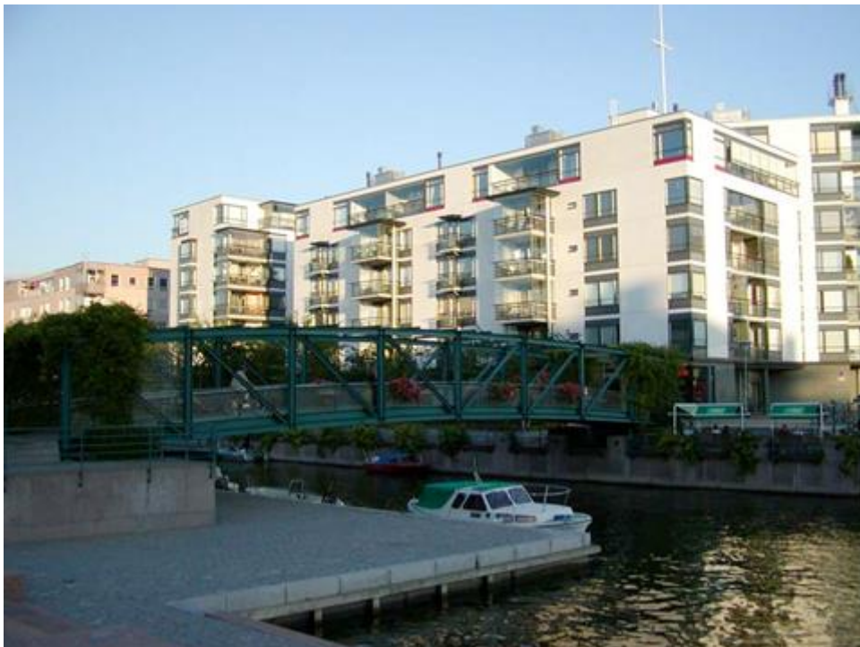
Folie 152: Wohngebäude 5- 6geschossig, (Quelle: Güldenber, 2013)
