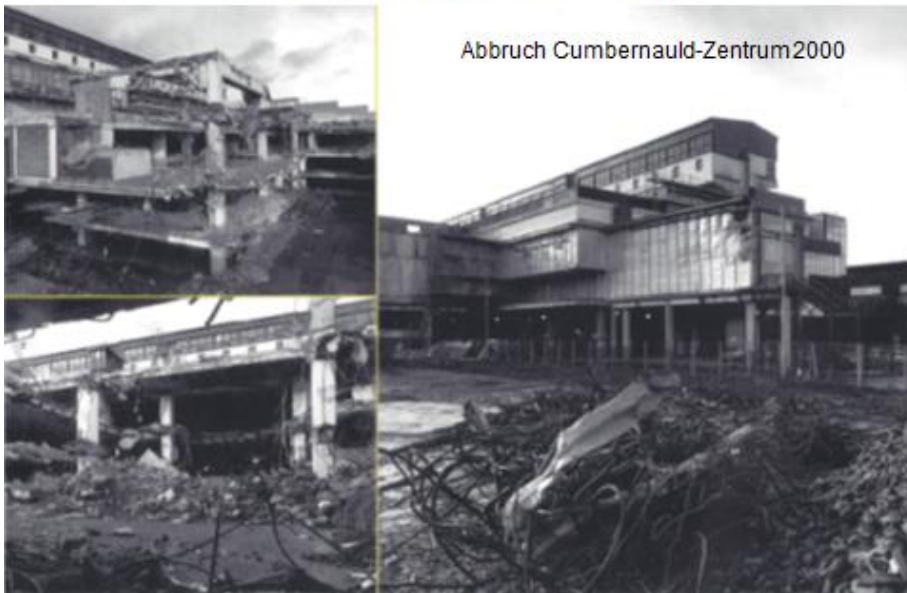
Folie 91: Abbruch Cumbernauld Zentrum, 2000, (Quelle: Bullivant, S.49)
