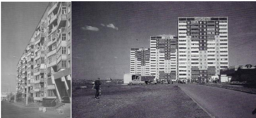
Folie 70: links: Großtafelbauweise 60er-70er Jahre, (Quelle: Bauwelt 48/1995, S. 2789), rechts: Plattenbauweise 80er-90er Jahre, (Quelle: Bauwelt 48/1995, S. 2793)
