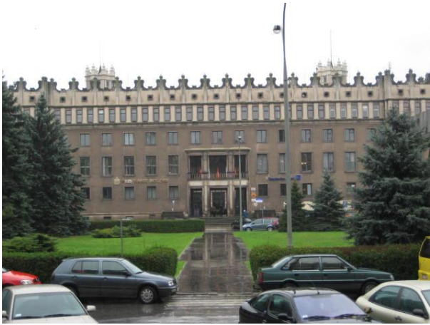
Folie 83: Verwaltungsgebäude der Stahlwerke mit Zinnenkranz
