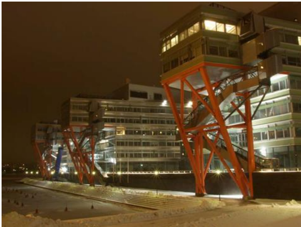
Folie 150: Dienstleistungsgebäude nachts, (Quelle: Güldenberg, 2013)
