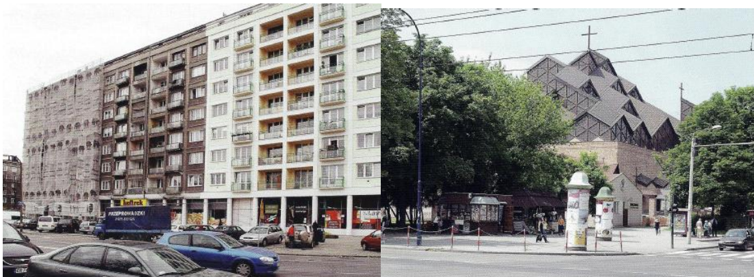
Folie 84: links: Osiedle Centrum, Sektor B 1956 bei der Sanierung, (Quelle: Rojkowska-Tasak/Ciepiela, S. 184); rechts: Kirchenneubau 1982
