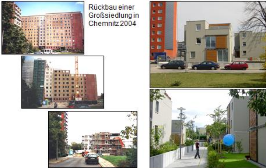
Folie 133: Rückbau einer Großsiedlung in Chemnitz, (Quelle: Handlungskonzept Wohnen für Chemnitz, Stadtbüro Hunger, 2005)
