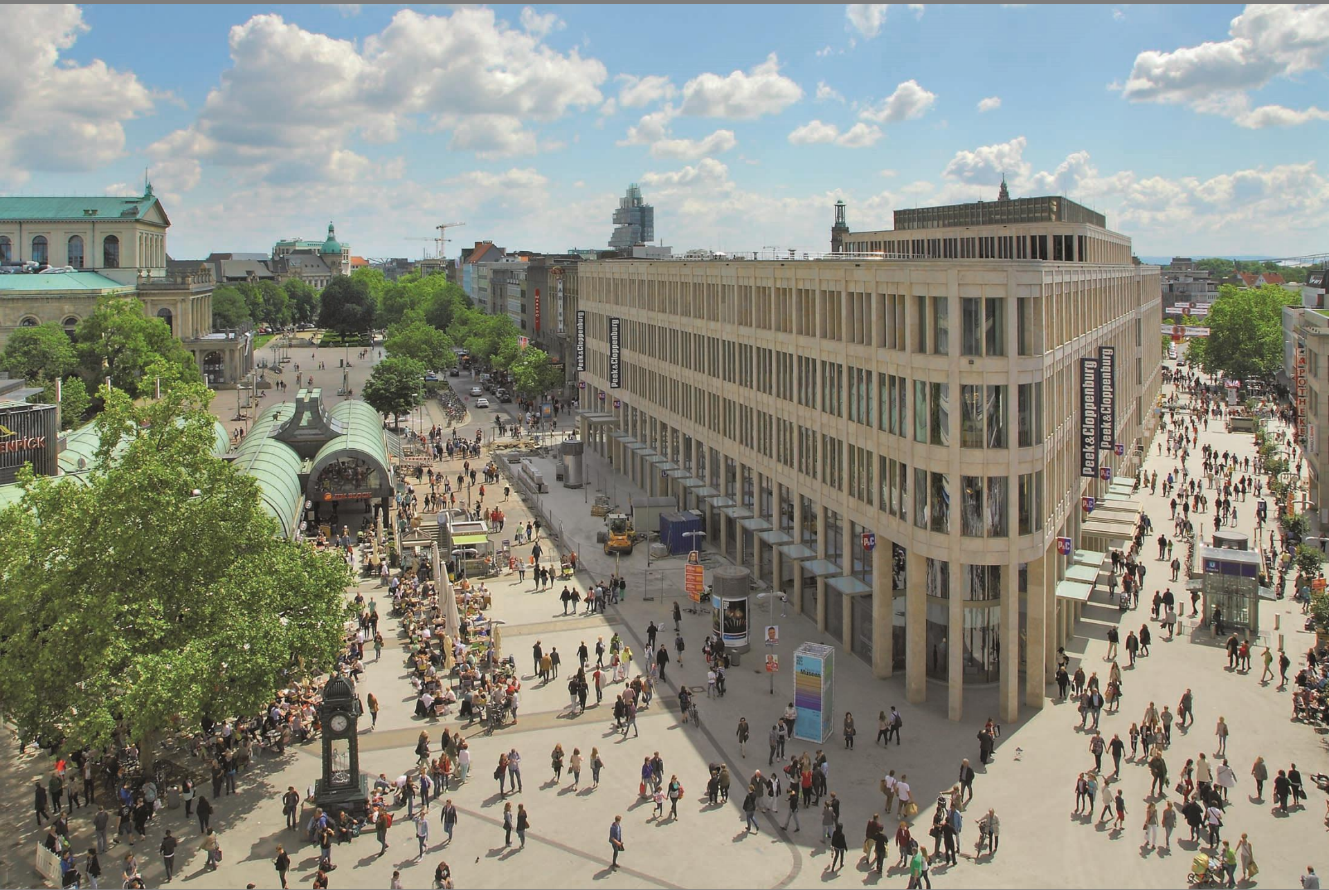
Umbau Kröpcke-Center, Arch. Jan Kleihues, 2015
